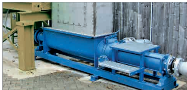
Plnění čerpadla za drtičem
